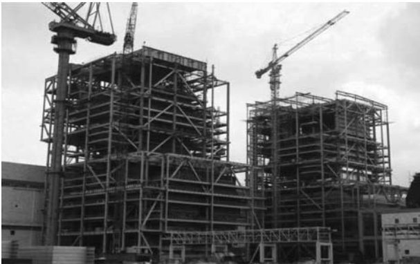
图5 建设中的电站锅炉
