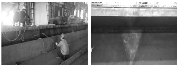
图 19 采用三角法火焰矫正↑
