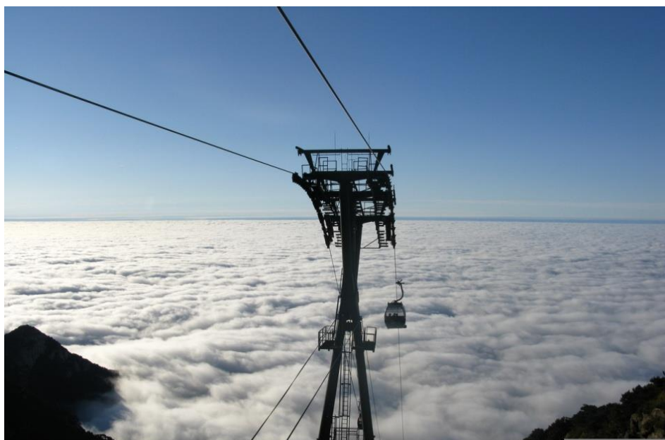
图 15: 客运架空索道
