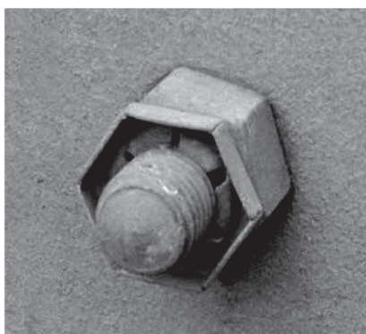
图九采用双螺帽时内螺帽需使用重型六角螺帽，外螺帽可采用一般螺帽。
