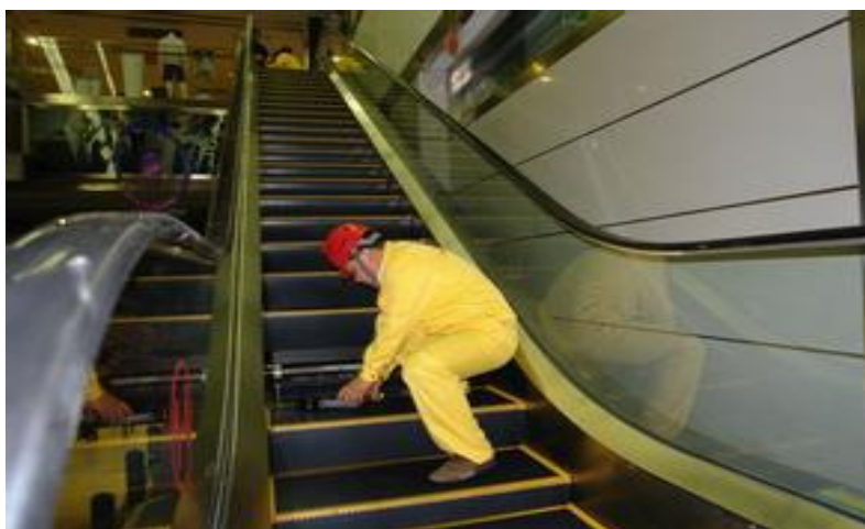
图 23：检验人员在对电梯进行检验
