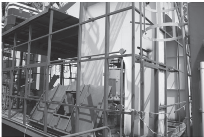
图2 事故现场照片
