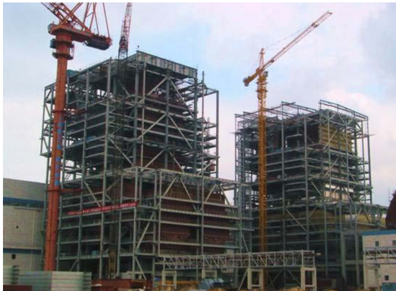
图 5：建设中的电站锅炉
