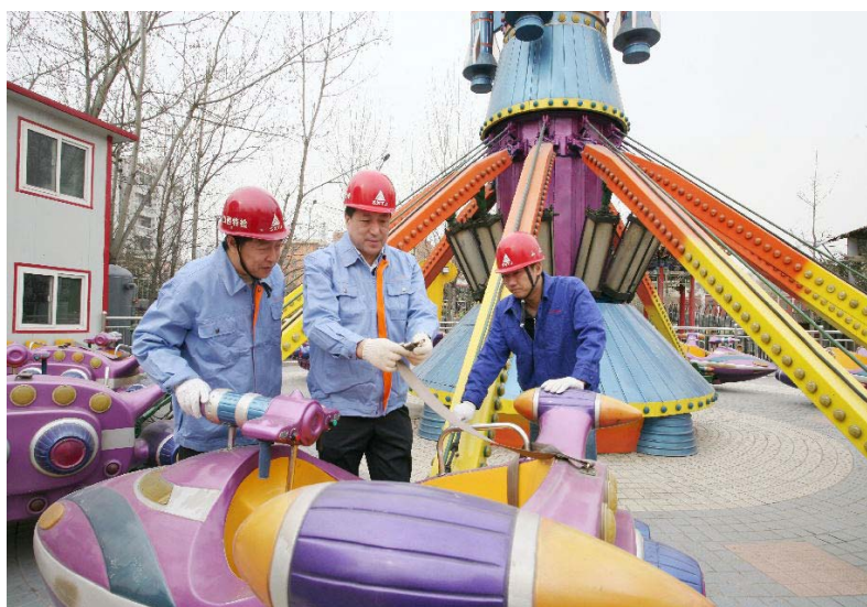
图 23：检验人员在大型游乐设施进行检验
