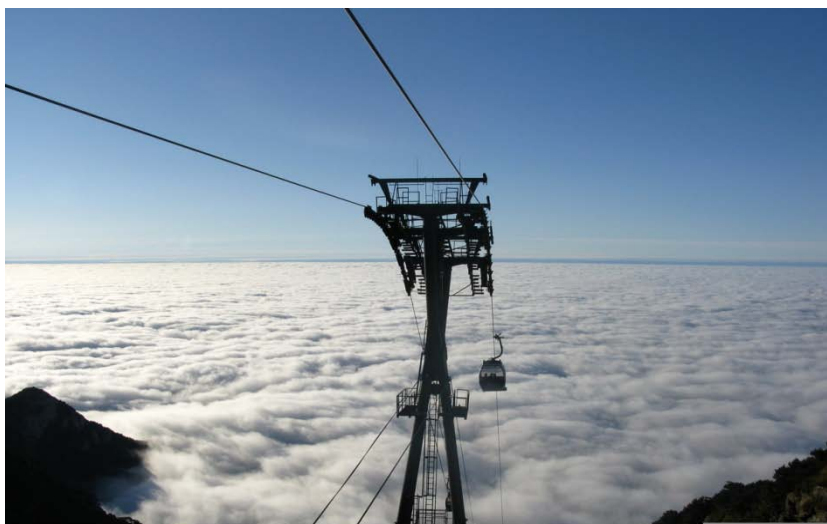
图 14：客运架空索道
