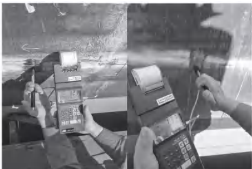
图 11 现场检测储罐焊接完成的 B1 环焊缝表面硬度
