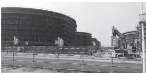
图 1 某输油站迁建项目储罐群
