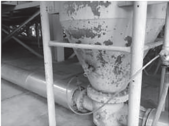
图1 电除尘第一电场下方的放灰口取灰口
