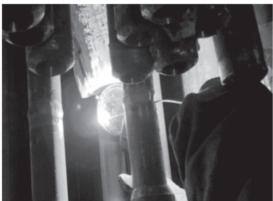
图 8 改变焊丝形状镜面焊焊接
