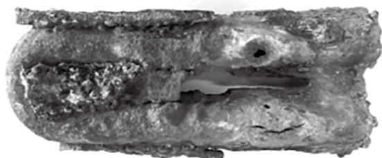
图 1 开裂水冷壁管道宏观照片
