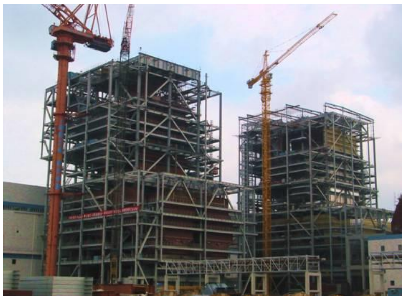
图 5：建设中的电站锅炉
