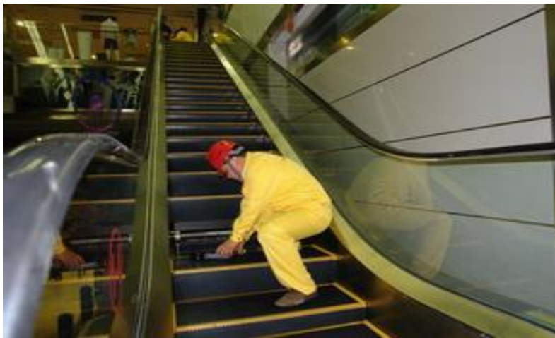
图 22：检验人员在电梯进行检验
