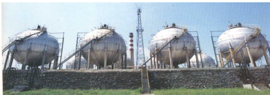
图 6 固定式压力容器（球形储罐）
